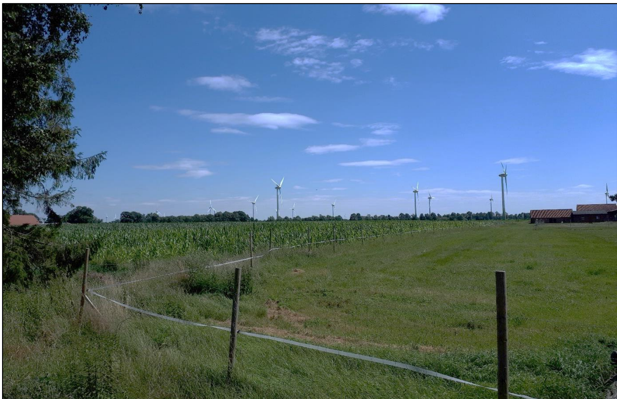
Abb. 4: Blick auf Teile des Bestandwindparks aus nordwestlicher Richtung
