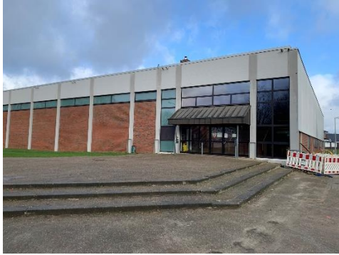
Desolate Sporthallegebäude im Bereich Großer-Kamp-Ost
