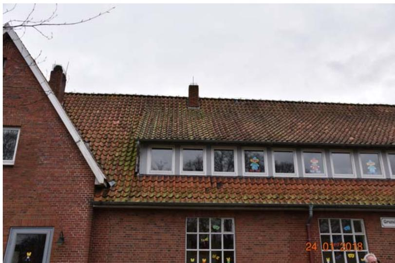
Das zweischalige Außenmauerwerk besteht aus roten Ziegelsteinen. Die Hohlchicht zwischen der Außen- und der Innenschale wird etwa zwischen 5 bis 7 cm breit sein, denn die Wanddicke wurde überwiegend mit 32,5 cm incl. Innenwandputz ermittelt. Konkrete Feststellungen zum Wandaufbau, die über die visuelle Augenscheinseinnahme hinausgehen, habe ich nicht getroffen.
