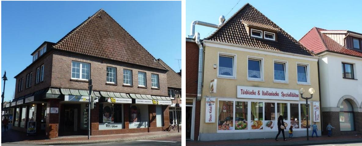
**Abbildung 12:** Beispiele für Sichtmauerwerk (links: Kirchstraße 2) und Putzfassade (rechts: Bahnhofstr. 9) (Quelle: SWECO 2014)
