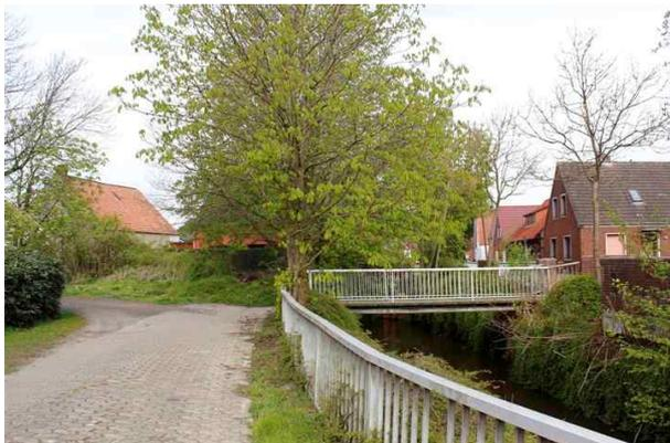
**Abbildung 38: Öffentliche Fußgängerbrücke - Verbindung Wasserstraße - Sieben Provinzen: zu schmal für Radverkehr**
