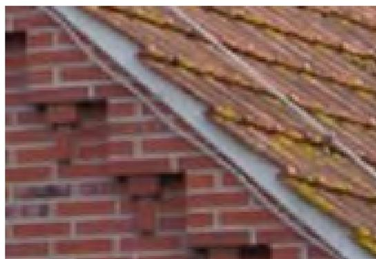
Abb. 115: Beispiele zur Ortganggestaltung (Windfeder, Ortgangziegel mit Unterzugbrett und Mauerwerksfries)
