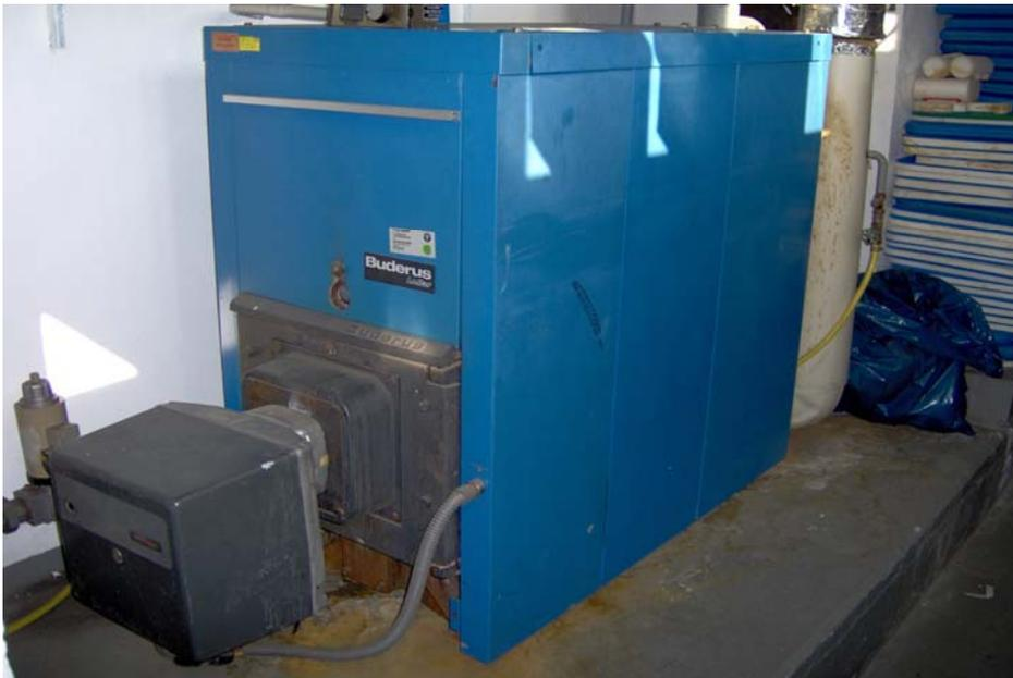
Die Anlage ist 22 Jahre alt, Wasserflecken und Korrosion am Kesselboden zeigen, dass es in der Vergangenheit zu Leckagen gekommen ist. Die Anlage ist abgängig.
