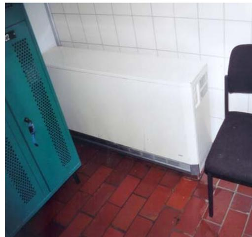
An einigen Stellen im Umkleibereich sind Feuchtigkeitsschäden zu erkennen, die auf eine nicht ausreichende Be- und Entlüftung zurückzuführen sind.
