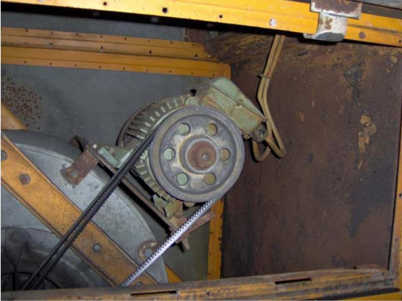
Abluftventilator mit Riemenantrieb im Luftstrom,
