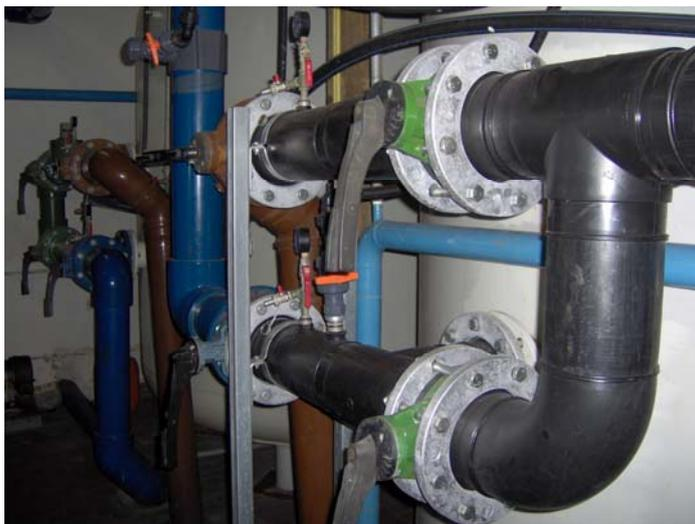
Im Vordergrund der Filter für das Nichtschwimmer Becken und im Hintergrund für das Schwimmerbecken im Freibad
